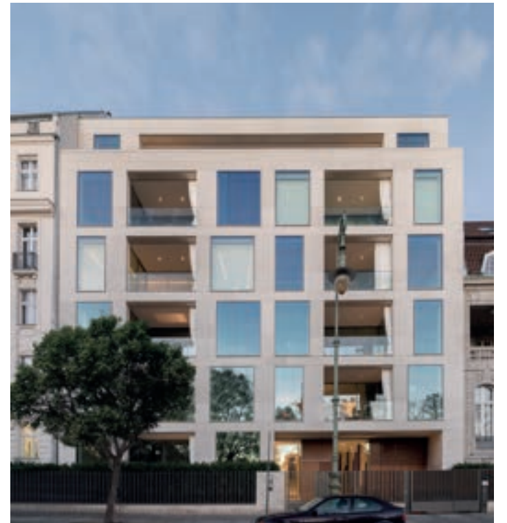
FERTIGGESTELLT / COMPLETED Wohngebäude / Residential building Witzlebenplatz 3 in Berlin
